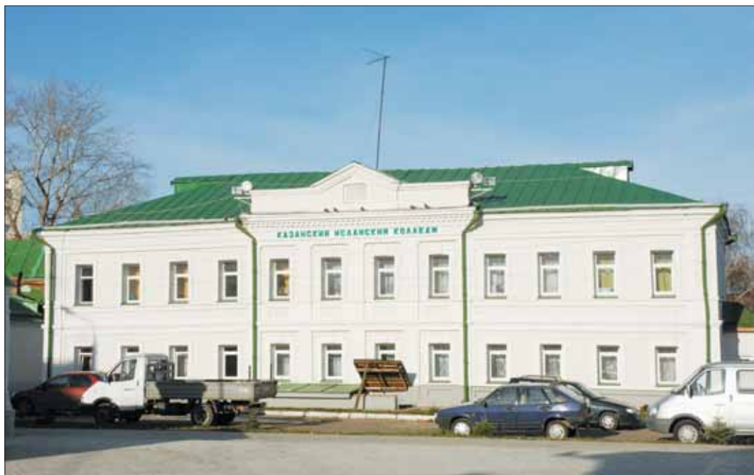
Здание медресе «Марджания». Современный вид
